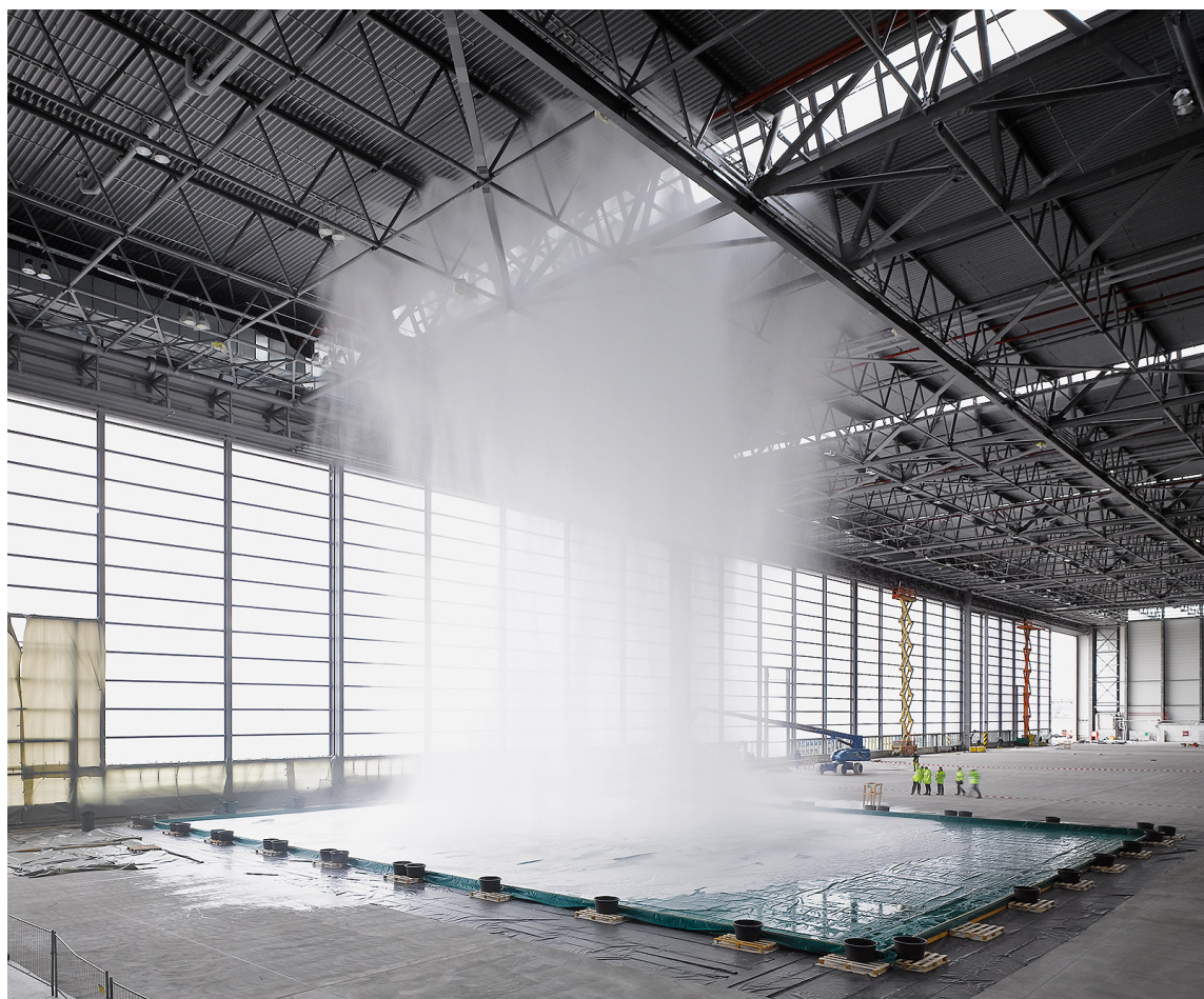
Sprühwasserlöschanlagen bekämpfen einen Brand auch bei größeren Brandlasten wirkungsvoll und in kurzer Zeit.
